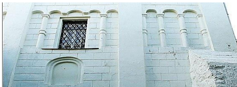
Рисунок 28. Аркатурный пояс с пилястрами
