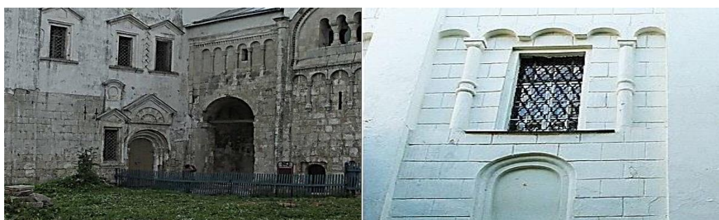
Рисунок 41. Аркатурный пояс с пилястрами
